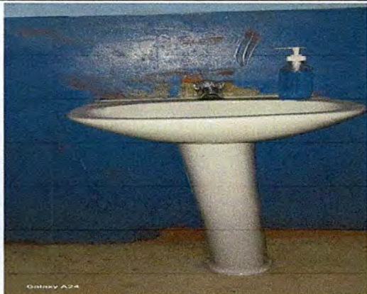
Foto 1: Mejoramiento de Servicios sanitarios y sus accesorios
