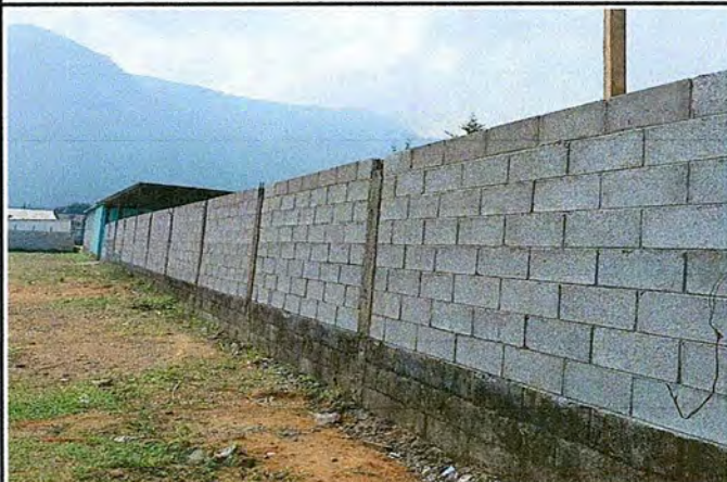
Foto 3: Finalización de Mjoramiento de Muro Perimetral
